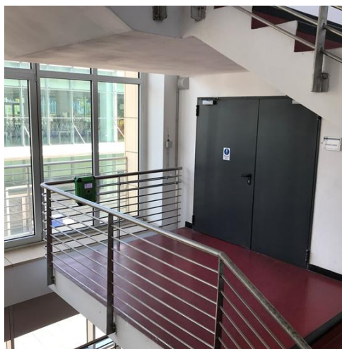
Fig. 3 Realizzazione spazi di attesa (Spazio Calmo) per persone con specifiche necessità, dotati di dispositivo di chiamata bidirezionale per la segnalazione della presenza – Polo Ferrari 1
