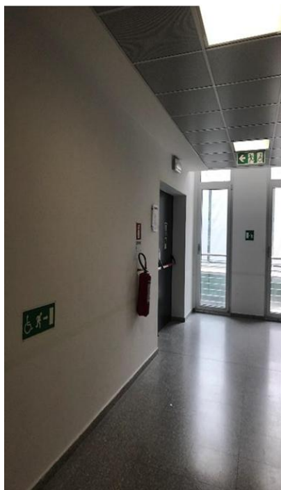
Fig. 2 Installazione di segnaletica fotoluminescente continua – Polo Ferrari 1
